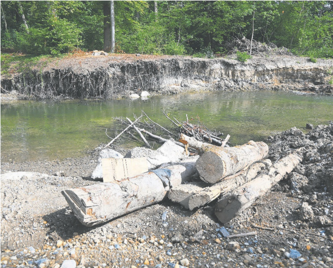
Das linksseitige Ufer wird mit Holz befestigt und gesichert, am rechtsseitigen Ufer kann sich die Natur frei entfalten.
